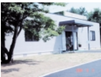
写真1 宇治構内に完成した UNITWIN 本部棟。
