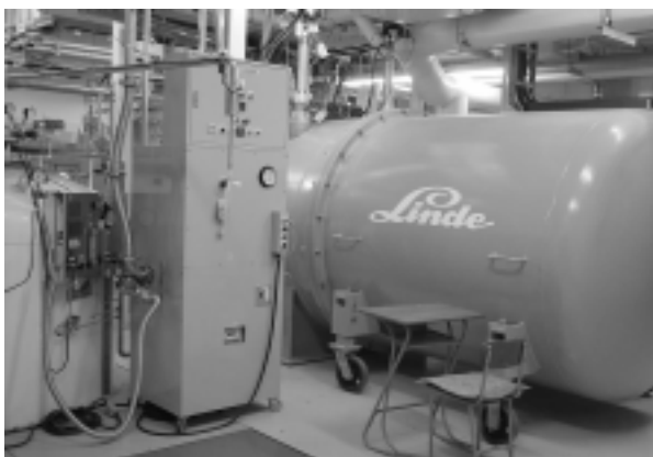
図 6 新しいヘリウム液化機． LINDE 社製モデル TCF-200．
