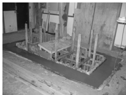
図 3 ピット型枠にコンクリートが 流し込まれたところ（2004 年 12 月）
